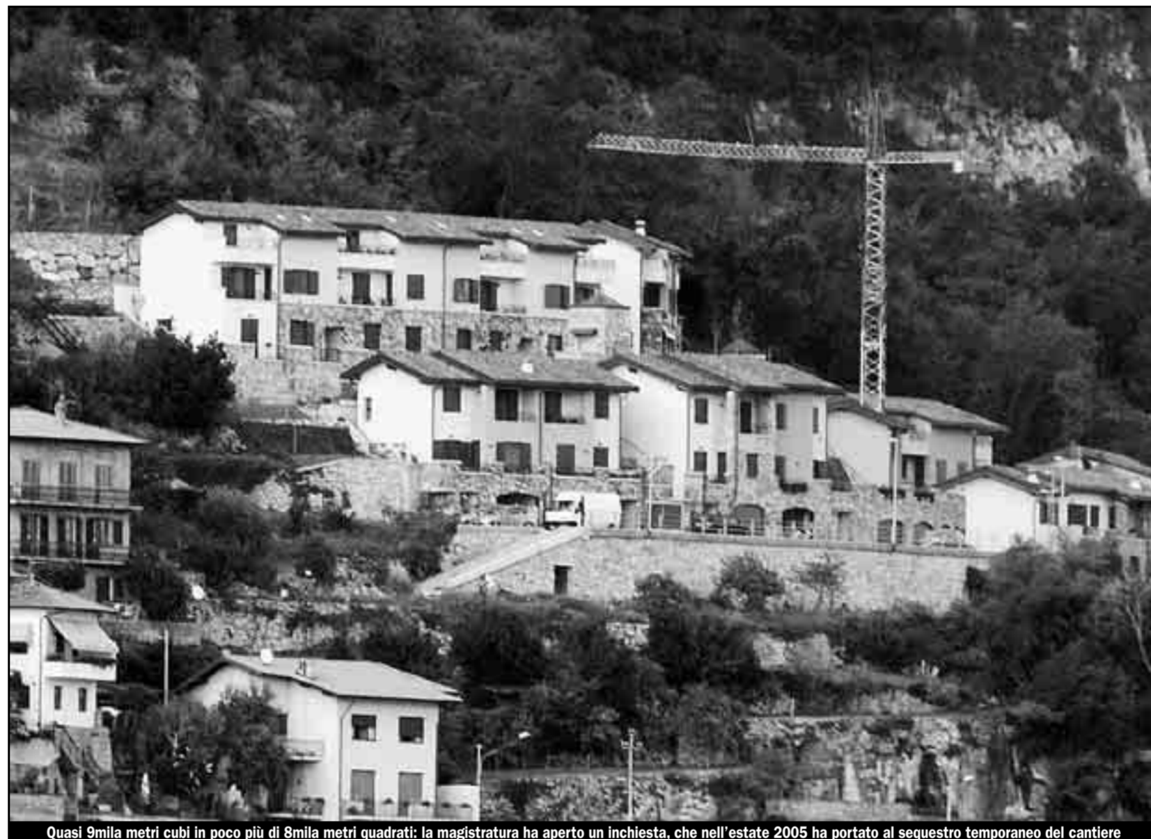
Quasi 9mila metri cubi in poco più di 8mila metri quadrati: la magistratura ha aperto un'inchiesta, che nell'estate 2005 ha portato al sequestro temporaneo del cantiere
