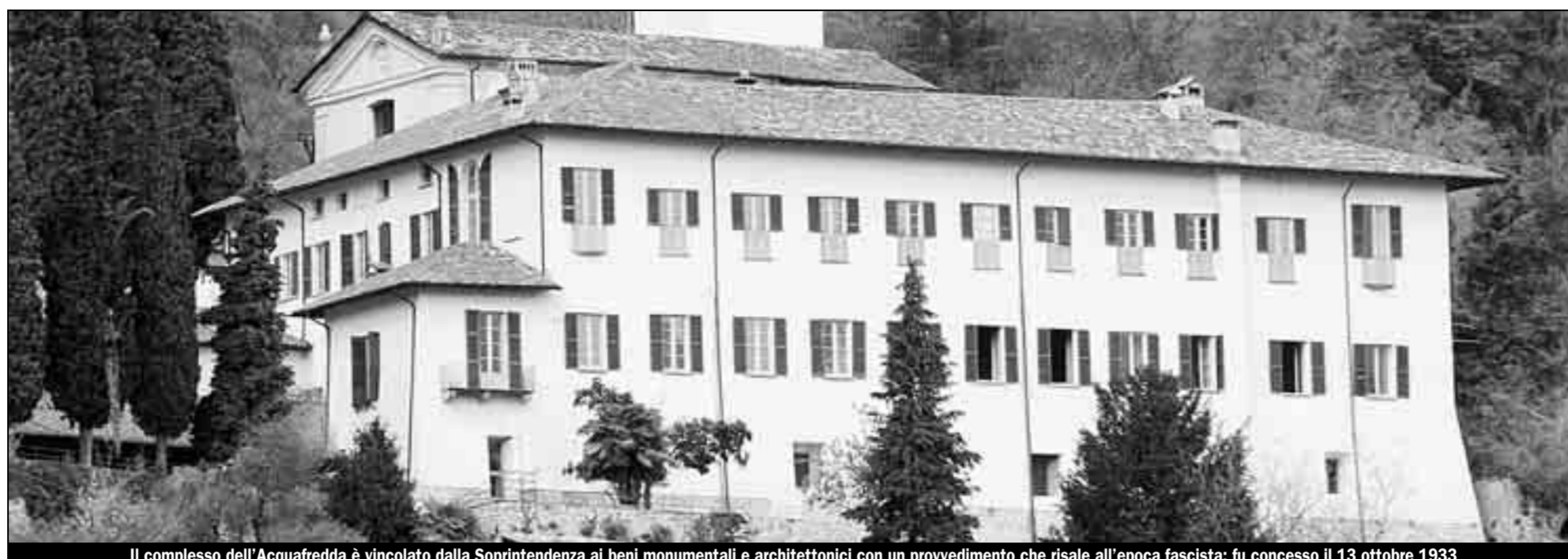
Il complesso dell'Acquafredda è vincolato dalla Soprintendenza ai beni monumentali e architettonici con un provvedimento che risale all'epoca fascista: fu concesso il 13 ottobre 1933
