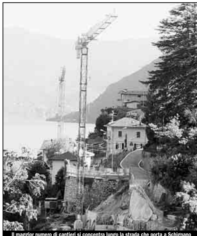
Il maggior numero di cantieri si concentra lungo la strada che porta a Schignano
