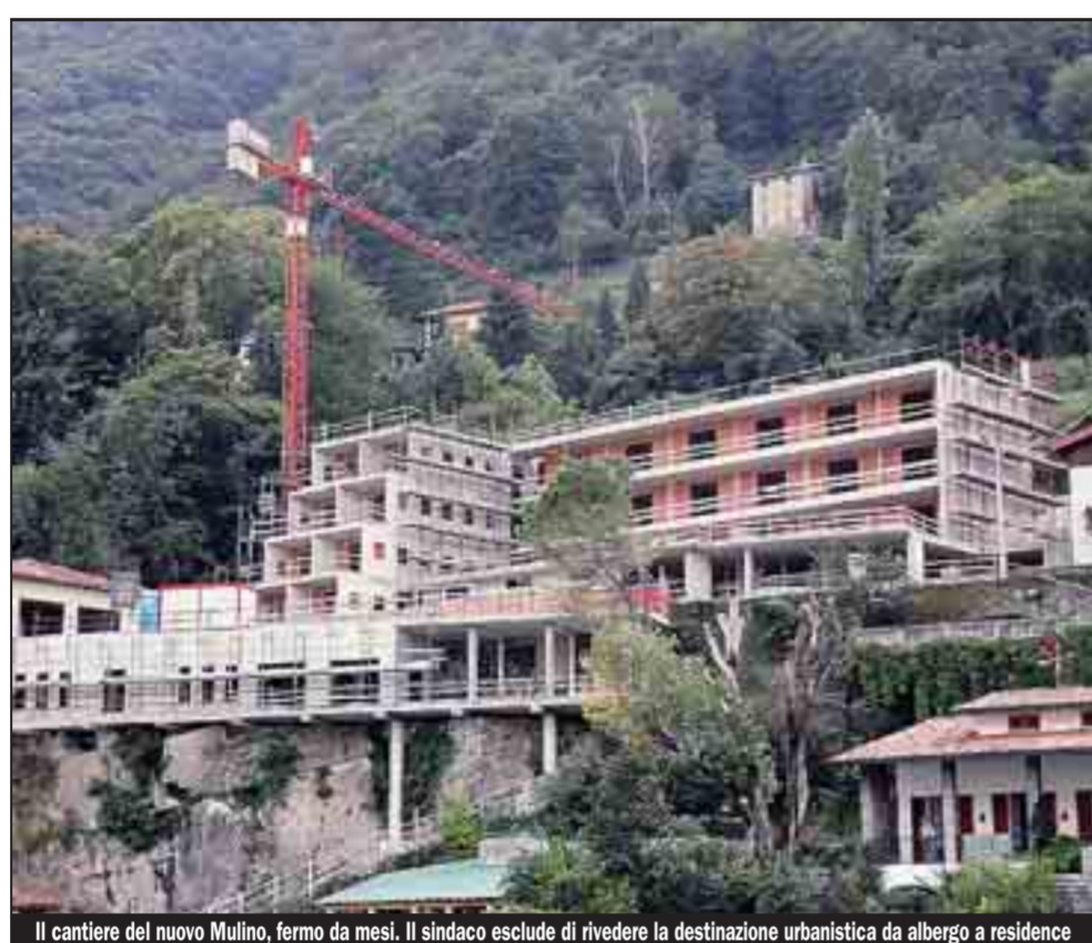
Il cantiere del nuovo Mulino, fermo da mesi. Il sindaco esclude di rivedere la destinazione urbanistica da albergo a residence
